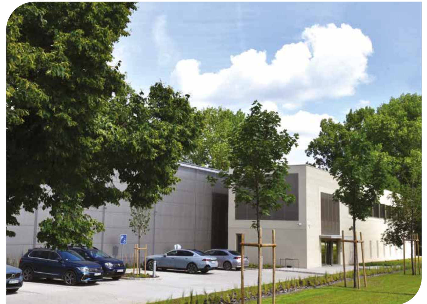
→ 1. KÉP: ELŐL (JOBBRA) AZ ÚJ BORÁSZAT IRODAÉPÜLETE, MÖGÖTTE (BALRA) A BORÁSZATI SZÁRNY
